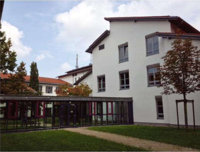
Seminargebäude von Süden
