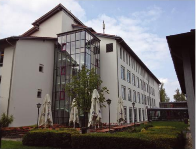
Treppenhaus von Süden
