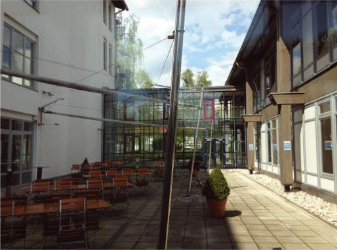
Innenhof zwischen Seminar- und Verwaltungsgebäude
